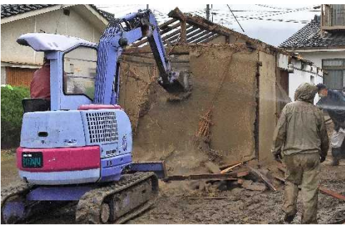
雨の中、↑瓦の撤去 ↓土壁の撤去
