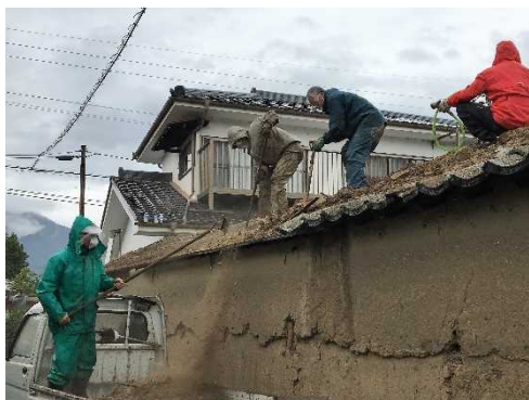
雨の中、↑瓦の撤去 ↓土壁の撤去
